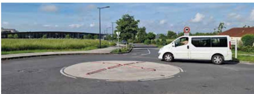
Des séparateurs sont installés sur le rond-point du carrefour de la rue du Bleu Nacré et de la route de l'échassier. Ils sont destinés à empêcher le franchissement de ces ronds-points par les véhicules, obligés de les contourner et donc de limiter leur vitesse.
