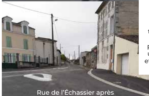
Rue de l'Échassier avant
