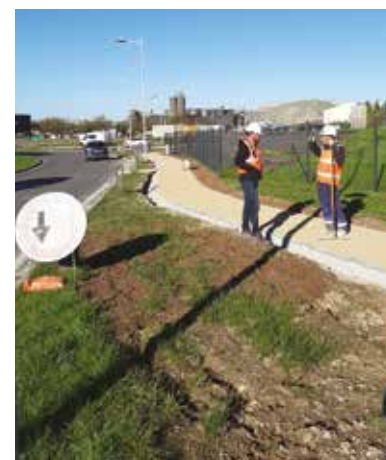
Création par Grand Cognac d'une liaison douce dans la zone commerciale du Mas de la Cour.
