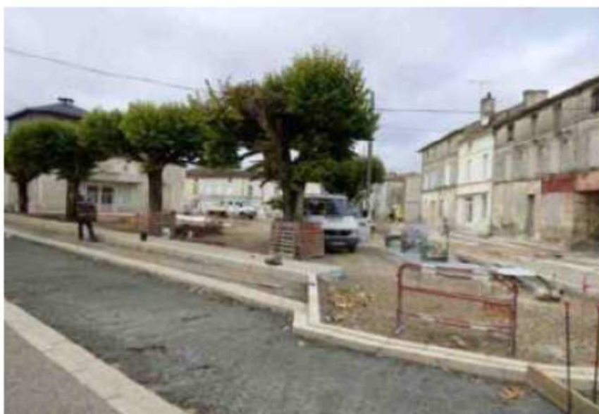
Les travaux du chantier d'aménagement autour de la salle des fêtes s'achèveront à la fin de l'année 2019. PHOTO ALAIN MICHAUD
