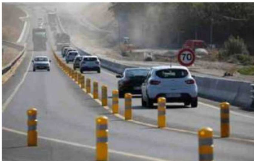
Les travaux débutent ce lundi pour se terminer vendredi 5 novembre. PHOTO ARCHIVES LOÏC DÉQUIER
