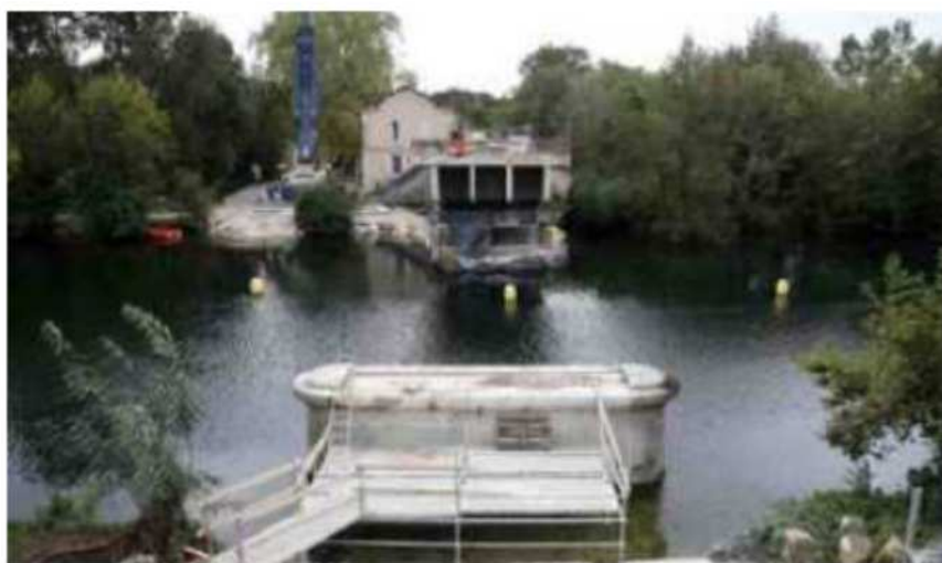
Une vue du chantier, en fin de semaine dernière. PHOTO LOÏC DEQUIER
