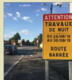
Le chantier va être mené de nuit, rue de Montplaisir.
