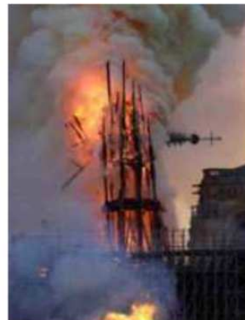
Des tonnes de plomb de la charpente de la flèche ont fondu pendant l'incendie.
