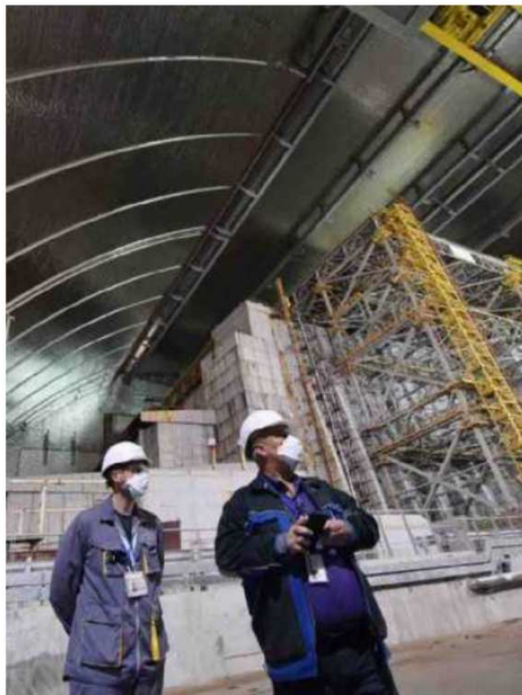
L'arche géante au-dessus du sarcophage de béton a fini d'être installée en 2016 et doit durer cent ans. PHOTO AFP
