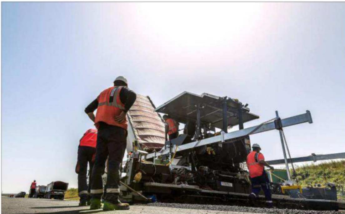
L'enrobé déversé sur la chaussée, ici à la Vigerie sur le chantier de la RN 141, est à une température de 150 degrés.
