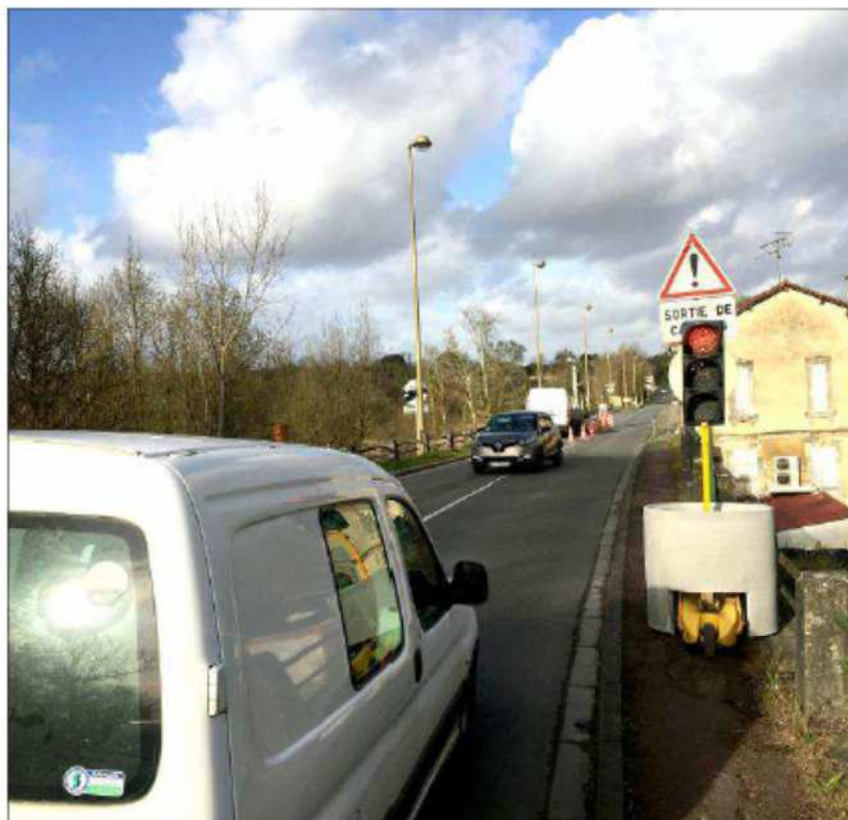
Sur ce pont à la circulation très chargée, les cyclistes devront se contenter de trottoirs plus larges que les actuels pour le franchir après sa reconstruction.
