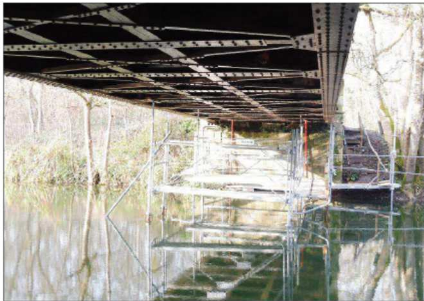
Une partie du dessous de l'ouvrage désormais nettoyée.
