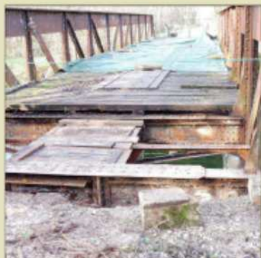
Des crédits sont accordés pour les travaux du pont de fer. Photo CL
