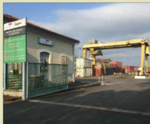
La plateforme Naviland Cargo reste en place à Cognac... en attendant une possible réouverture de la ligne.
