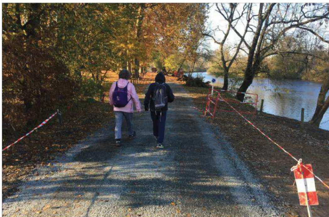
La Flowvélo poursuit sa progression sur le territoire et se concrétise à Bourg-Charente où les travaux vont bon train.
