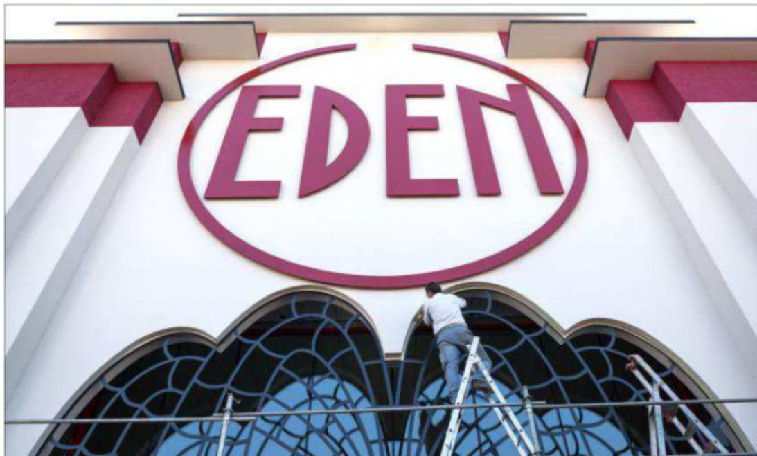
La façade de l'Éden, inscrite à l'inventaire supplémentaire des Monuments historiques en 1984, a été reconstruite à l'identique. Les vitraux qui surplombent l'entrée ont été posés il y a deux semaines.
