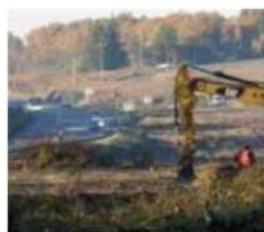
Les travaux entrent dans la deuxième phase. PHOTO ANNE LACAU
