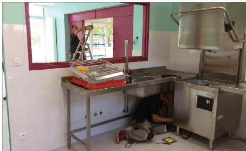
Gros chantier à la maternelle Saint-Exupéry. La salle de restauration a été entièrement refaite... Le chantier n'est pas tout à fait terminé.
