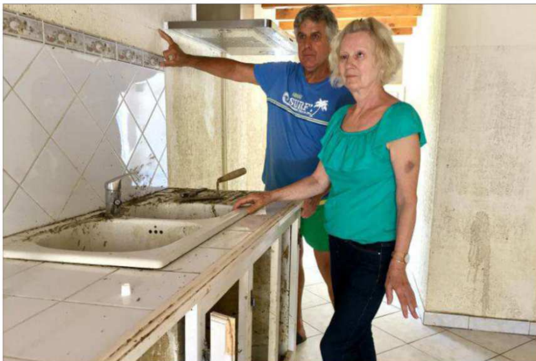
Chez le couple Marques, à Saint-Laurent-de-Cognac, la boue et l'eau, venues du ruisseau voisin, se sont infiltrées partout, jusque dans les tuyaux de la cuisine, ruinée.
