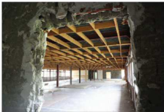
Les travaux se poursuivent désormais avec les confinements nécessaires.
