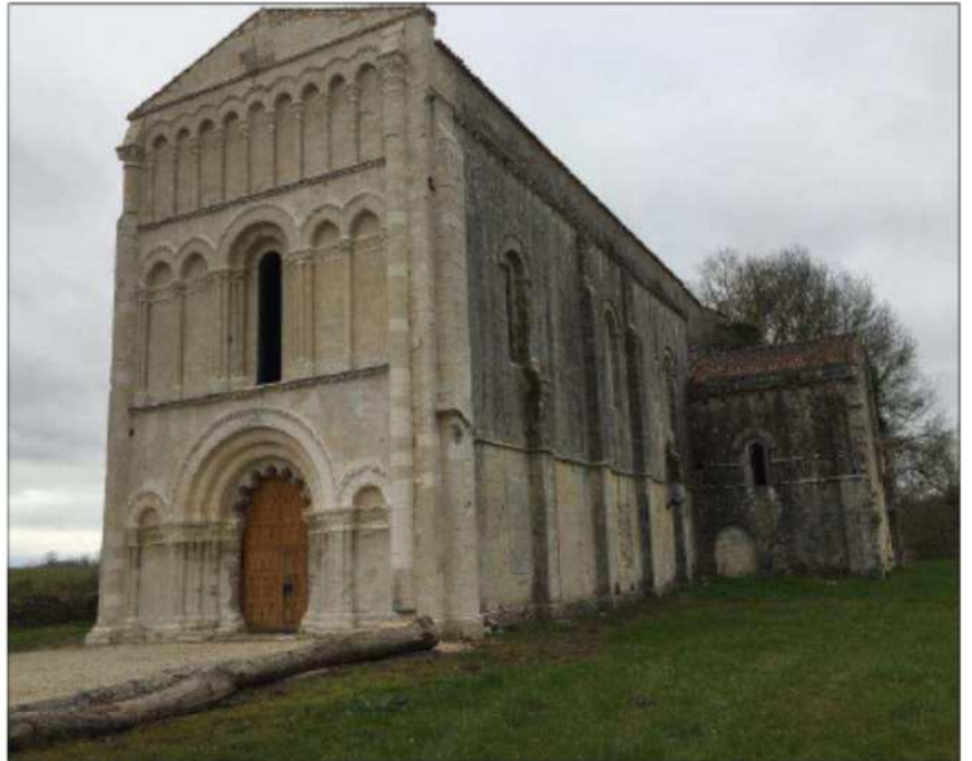
A droite de l'entrée, le transept sera rénové, de la charpente à la toiture. Photos M. B.
