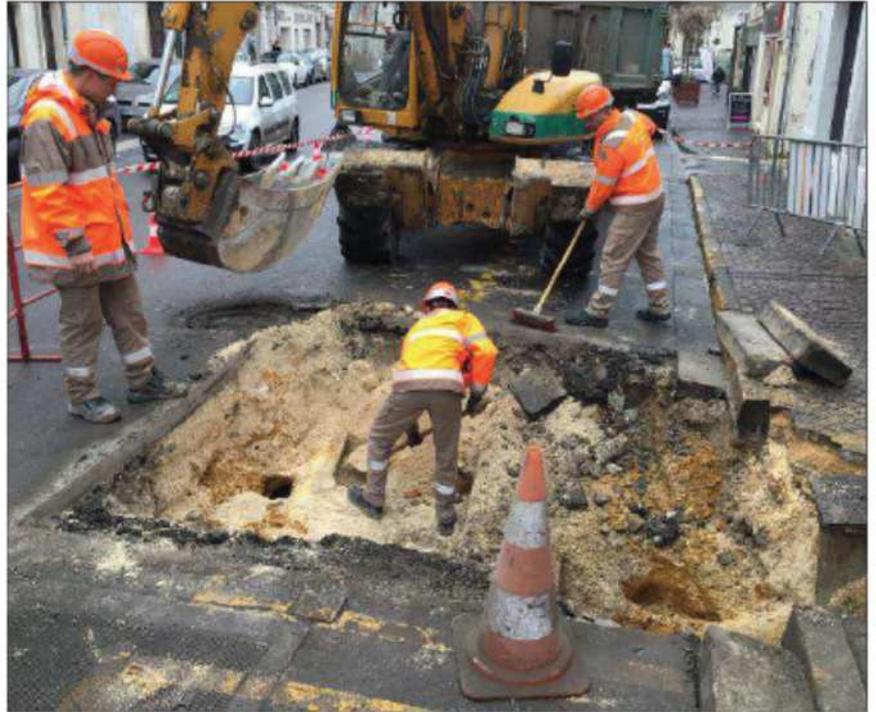
La plaque s'est enfoncée de 50 cm, ce week-end rue du 14-Juillet. En cause, un effondrement à 3,50 mètres de profondeur.
