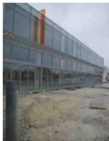
100 brise-soleil doivent être posés sur cette façade. P.H.M.
