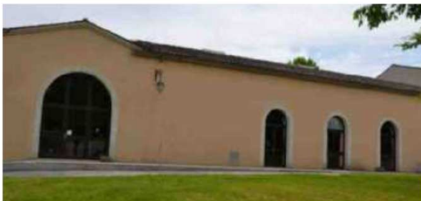
Les huisseries de la salle des fêtes vont être remplacées pour économiser de l'énergie. PHOTO C.-C. G.
