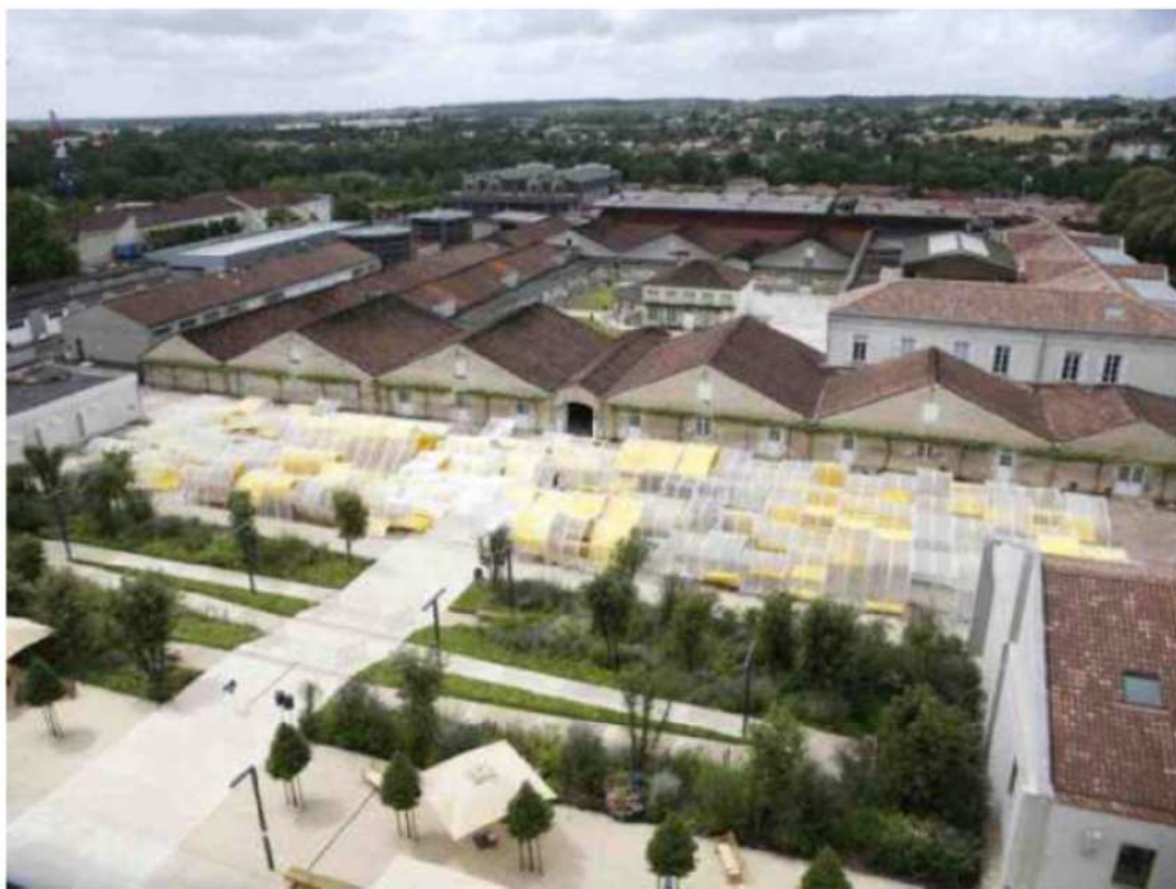
Vue du toit de la tour Martell. Le Pavillon s'étend entre l'esplanade et le circuit de visite. PHOTOS A.L.
