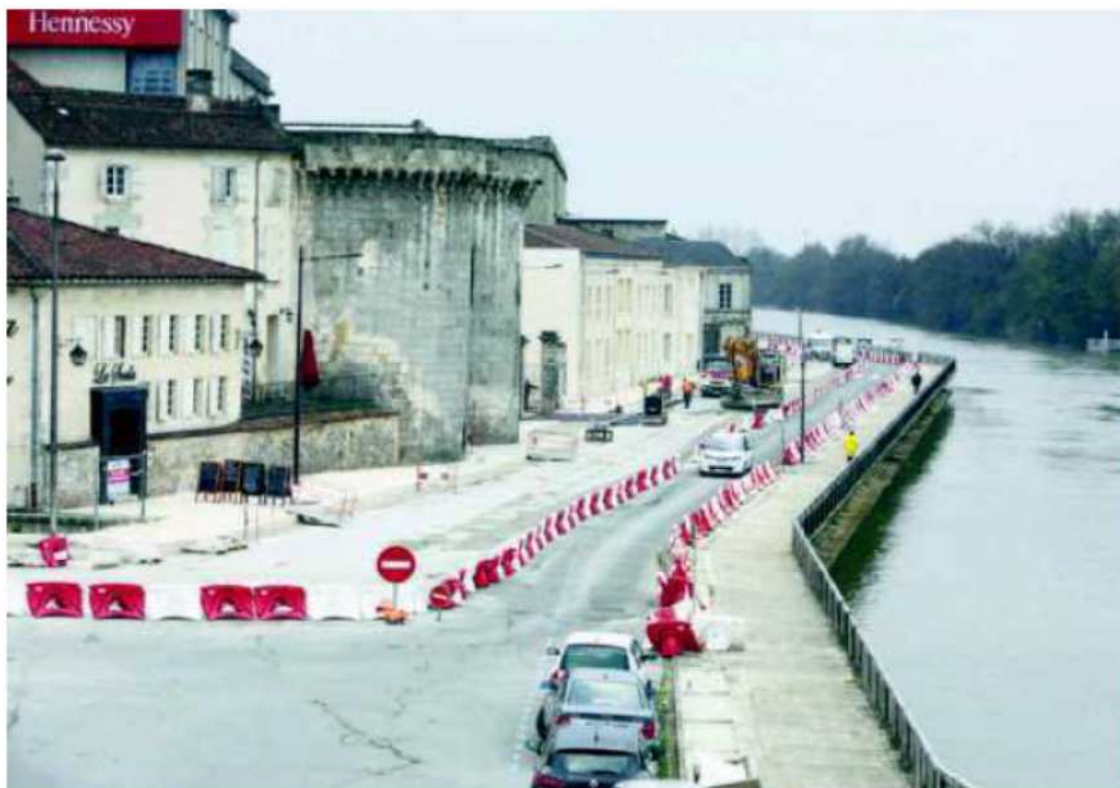
La première phase de travaux, lancée en janvier, concerne le trottoir et la voirie, côté façade. ALAICAUD
