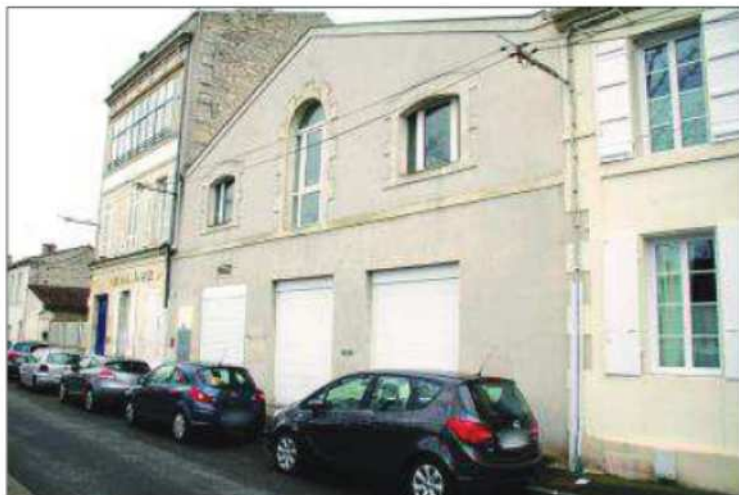
Propriété de la ville, le bâtiment qui abritait le Greta est sur la liste des biens à vendre.
