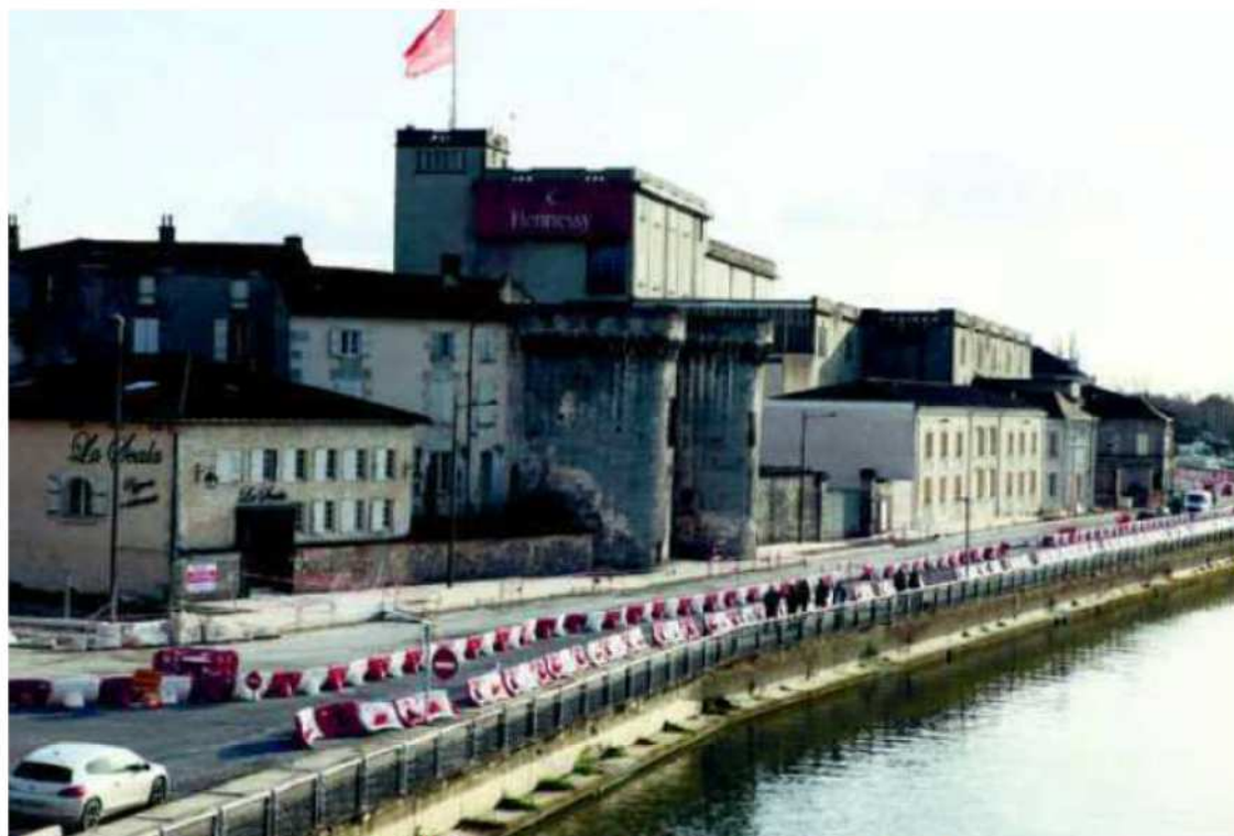
Le chantier des quais pèse 1,4 million sur les six millions d'investissements. PHOTO LINDA CHASSERIEAU
