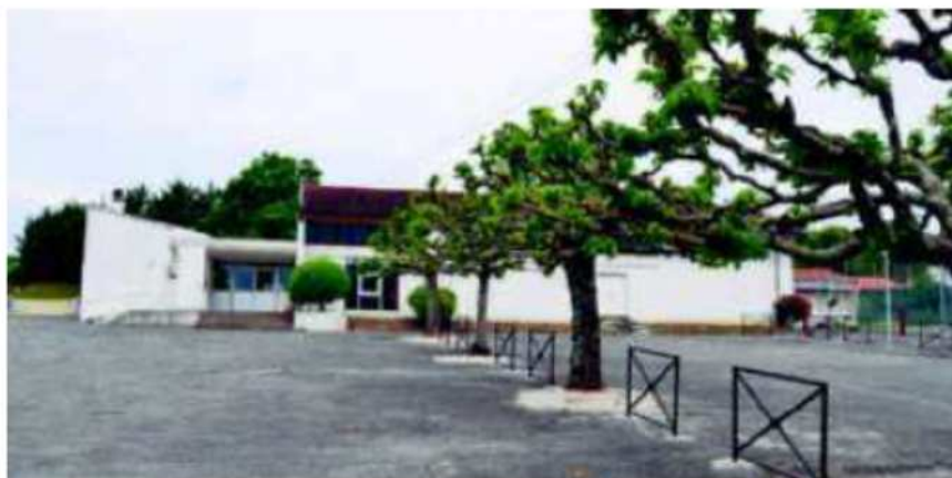
La remise aux normes de la salle des fêtes est à l'étude. PHOTO C. G.
