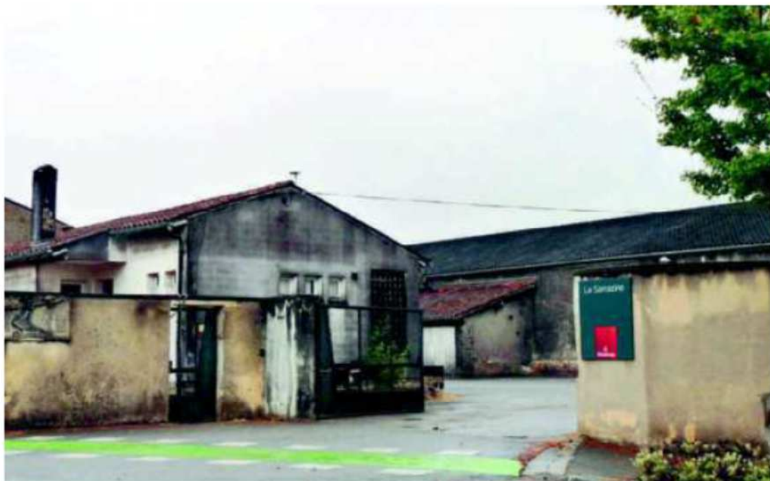
C'est sur le site de la Haute-Sarrazine que viendra s'installer le Pôle des métiers du cognac et du verre. PHOTO ARCHIVES S.J.
