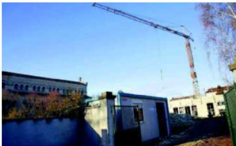
Le foyer, près de l'église Saint-Antoine, offrira une superficie de 600 m 2 et comptera neuf résidents. PHOTO ANNE LACAUD
