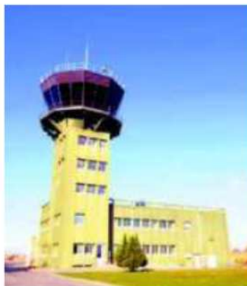
La structure de la tour de contrôle n'a pas été changée
