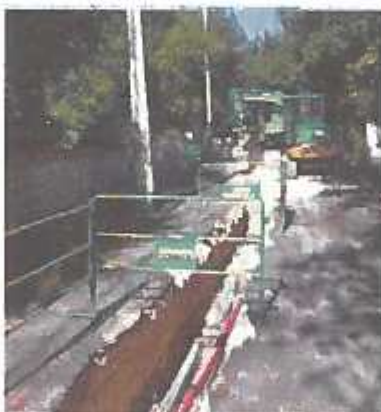
Les travaux d'effacement rue des Chênes devraient se finir prochainement. PHOTO SANDRA BALIAN
