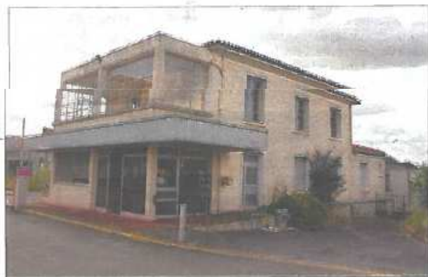
Des bâtiments à l'entrée de l'ancien hôpital pourraient être achetés pour être démolis et remplacés par la future assemblée de l'agglo et des bureaux.
