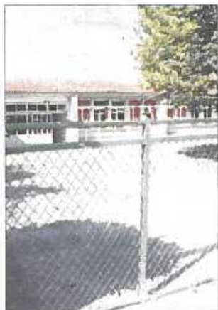
L'école de Brévilles a besoin de travaux urgents. ARCH. L. LOUVIER
