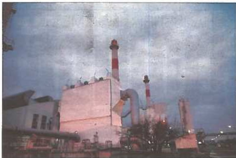
Au bas des trois cheminées, l'électrofiltre isole les poussières polluantes issues des fours. PHOTOS ANNE LACAUD
