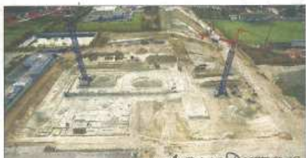
Le chantier de la super-piscine des Vauzelles à Cognac.
