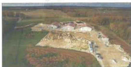
Les travaux d'implantation de la société Bache-Gabrielsen à Louzac-Saint-André.
