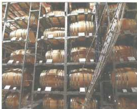
Dans les chais récents, les fûts de 400 litres sont répartis sur des «racks», de grandes étagères en métal hautes de près de 10 mètres.
