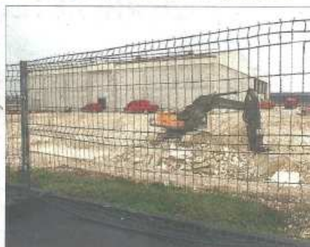
Le dernier chai actuellement en construction sera opérationnel dans quelques semaines. Ce sera le 38 e du site de Merpins-Bellevue.
