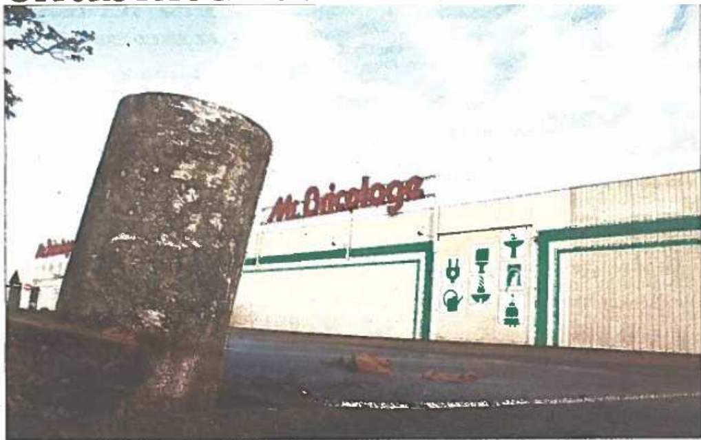
Vide depuis janvier 2014, l'ancien magasin Mr. Bricolage va être entièrement réhabilité. Travaux prévus à l'automne.
