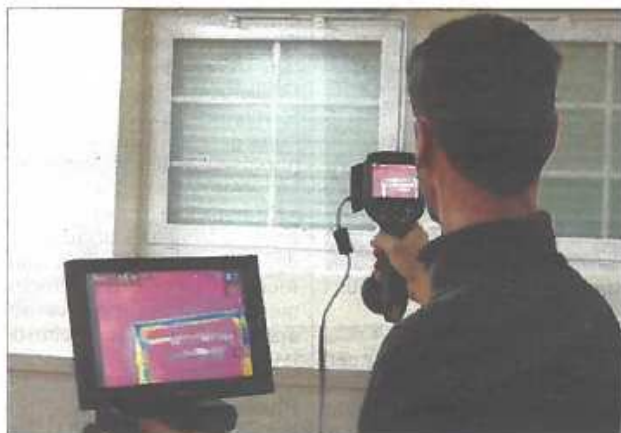
Le tour des fenêtres de la salle municipale de Mesnac est nettement plus froid. PHOTO P.B.
