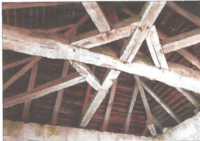
L'église, et notamment la toiture de la sacristie, fait partie des divers travaux programmés. PHOTO COLETTE-CHRISTIANE GUNÉ
