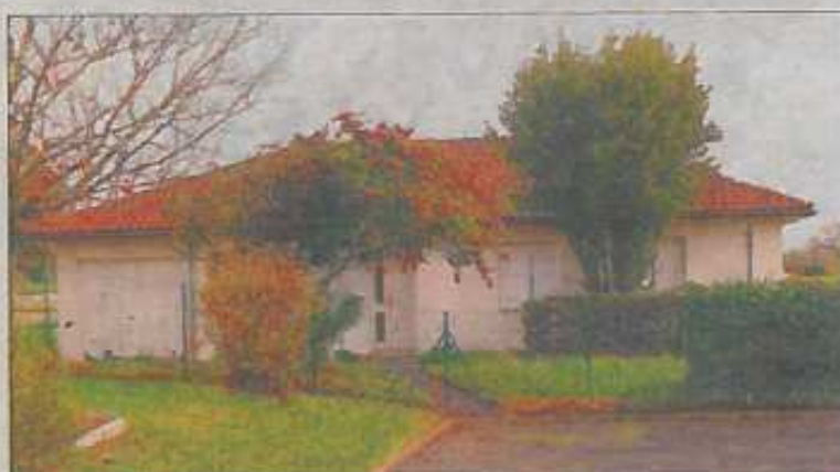
Le bâtiment qui accueillera la 4 e classe de maternelle.
