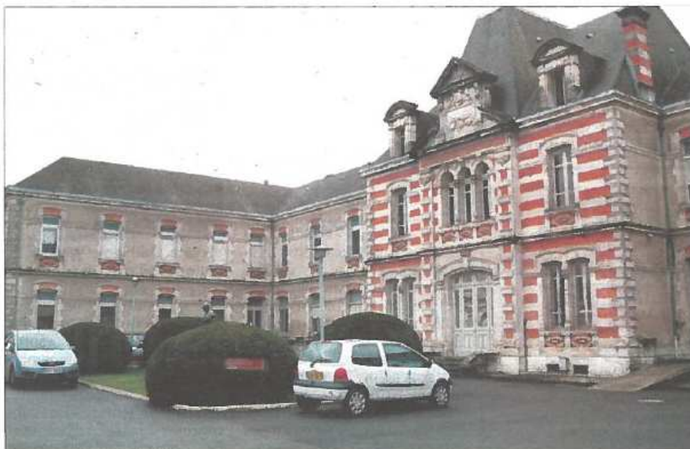
La moitié d'une aile et un étage du bâtiment Martell ne seront pas utilisés. Une marge de manœuvre qui laisse entrevoir l'avenir. PHOTO ARCHIVES ANNE LAGAUD
