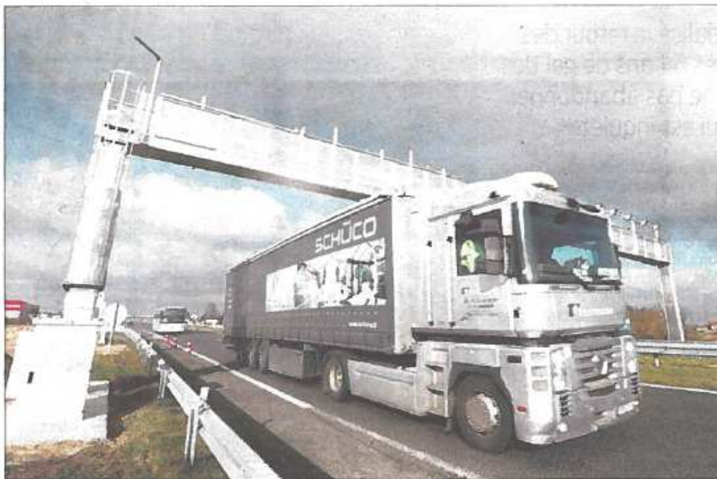
Les portiques destinés à enregistrer le passage des camions, en vue de percevoir l'écotaxe sur le fret routier, n'ont pour l'instant jamais servi. PHOTO XAVIER LÉOTY/W. SUD OUEST
