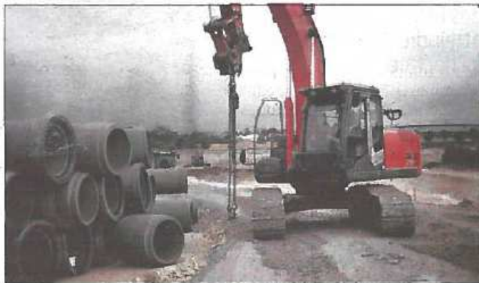
Le chantier, vu de l'avenue d'Angoulême. PHOTO OLIVIER SARAZIN
