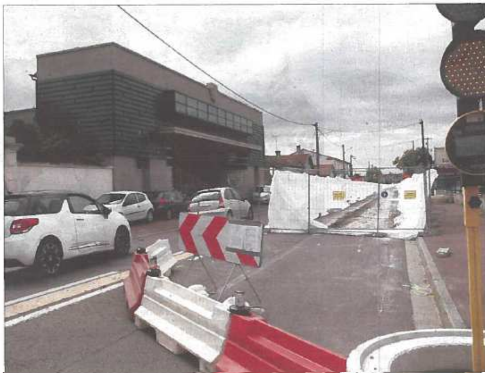
La circulation est rendue difficile par les travaux. PHOTO TIFFANY ARNOULD
