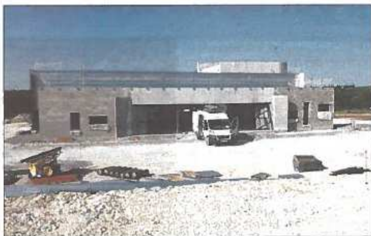
Le chantier de l'espace culturel et d'animations, début août.
