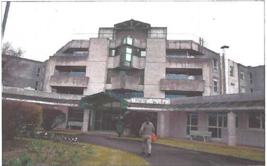
Bâtiment en mauvais état. Eau chaude coupée par une panne intermittente depuis deux ans. PH. S. C.
