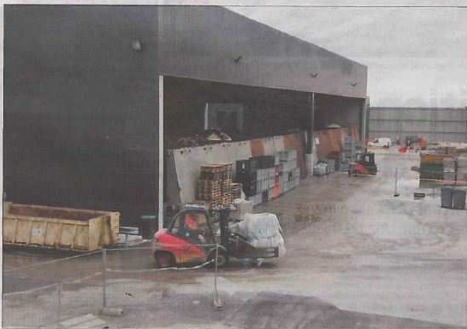
Hier matin, les employés se sont activés à nettoyer l'endroit du sinistre de mercredi. Les murs coupe-feu ont joué leur rôle, cette fois-ci. PHOTOS S. C.
