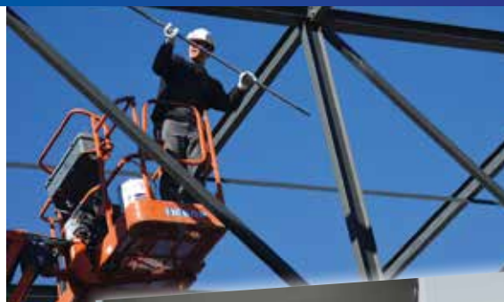
charpente métallique - DL Atlantique PERIGNY 17
