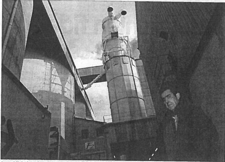
Jean-Michel Audouit au pied d'un des filtres installés sur les silos. PHOTO S. C.
