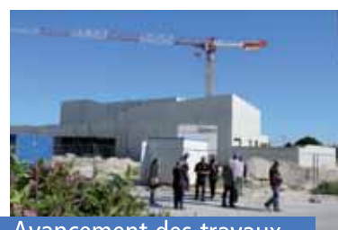
Avancement des travaux
