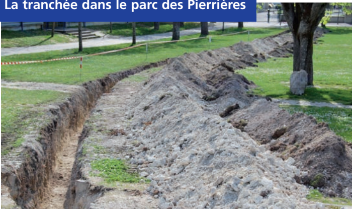
La tranchée dans le parc des Pierrières
