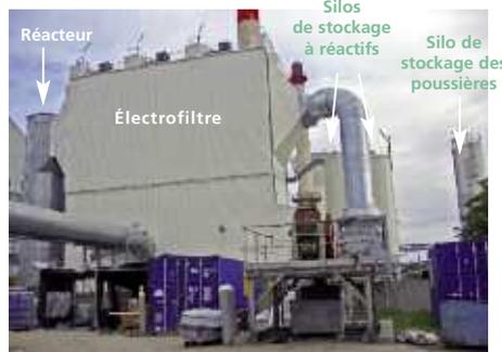
C'est chose faite : depuis fin 2008, les fumées sont captées avant leur sortie dans l'atmosphère et redirigées vers un électrofiltre via un réacteur. L'ajout de chaux transforme les acides gazeux polluants en poussières beaucoup plus faciles à « kidnapper ».
