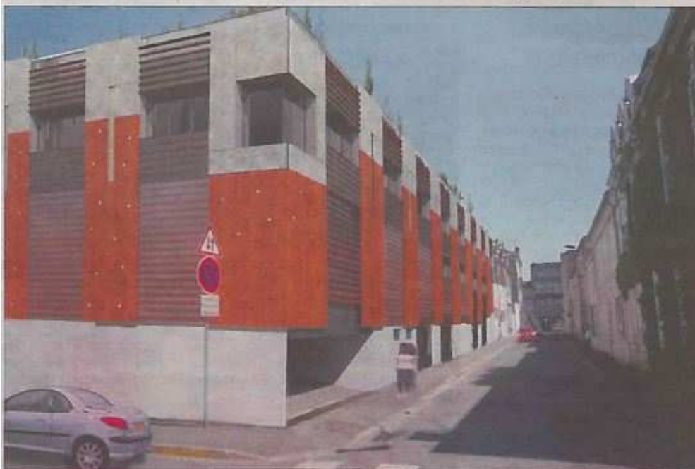
Projection de la rue Georges-Briand, avec l'entrée du parking aérien réservé aux bureaux
