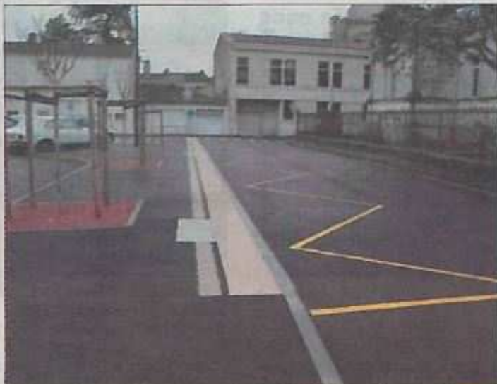
La place Gambetta - dont les travaux ont été terminés début décembre - a vocation à devenir un pôle multimodal.
