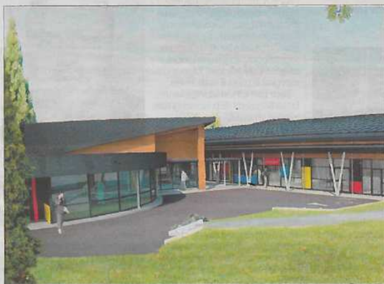
La partie nouvelle du site de Barbezieux, consacrée à la vente alimentaire (à gauche) et aux métiers de bouche (à droite), ressemble à une galerie marchande
